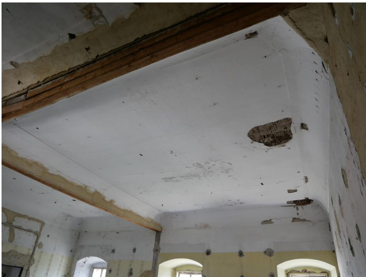
Foto 203 – sál ve 2.NP, značně poškozené omítané podhledy, určeno k plošnému sejmutí
