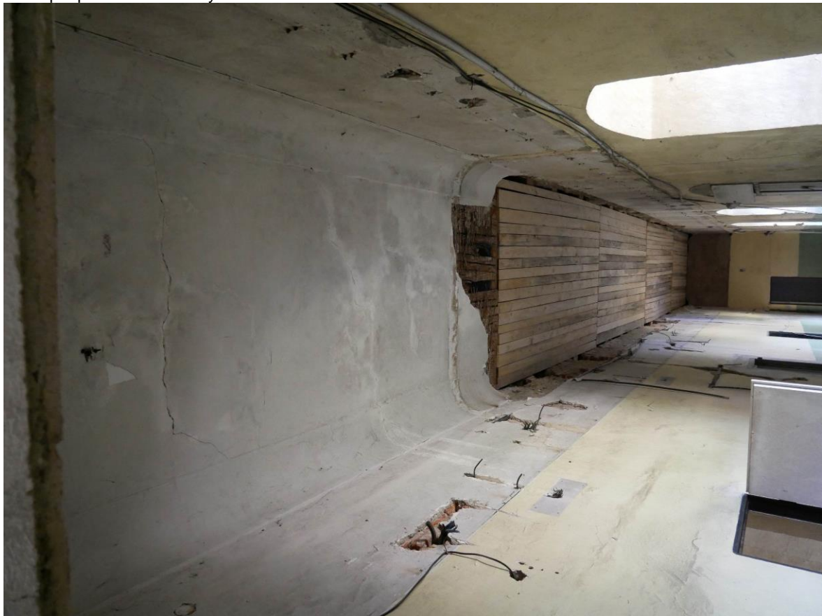
Foto 202 – strop chodby, omítaný pohled na rákosu, v pozadí díl pohledu po rekonstrukci v první etapě
