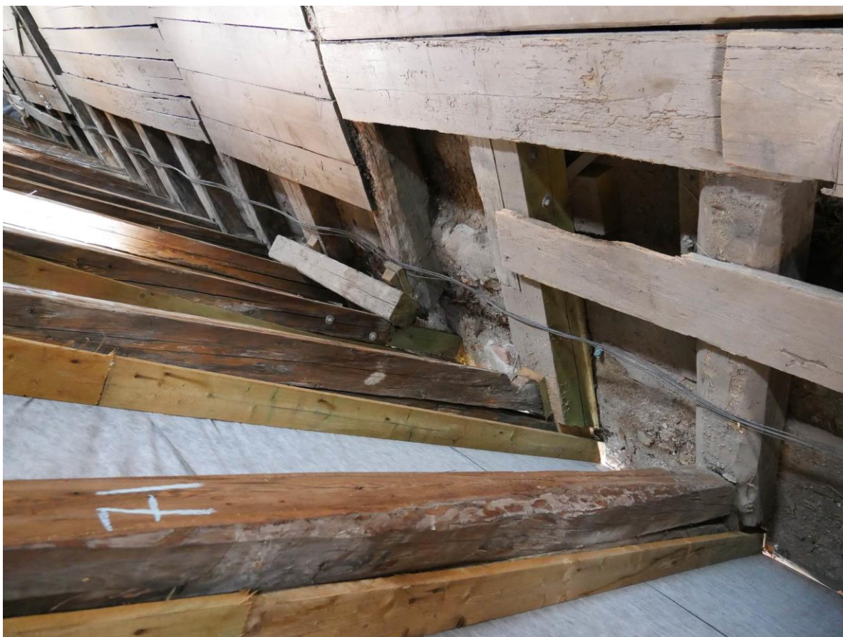
Foto 305 – detail poškození vazných trámů a destrukce pozednice, nepůvodní a nevhodné přiložkování krokví
