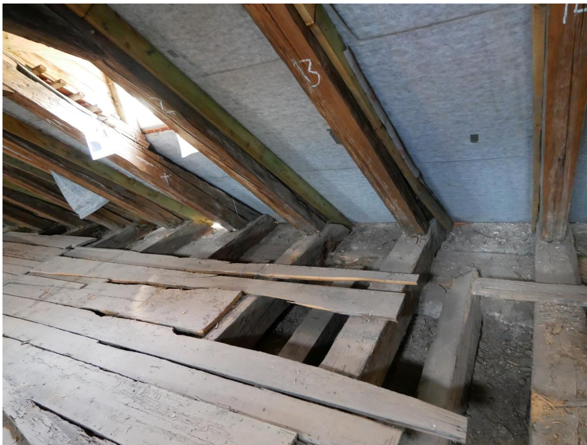
Foto 307 – provizorní podlahy, poškození vazných trámů, rákosníků a pozednice. Nevhodné příložky krokví.
