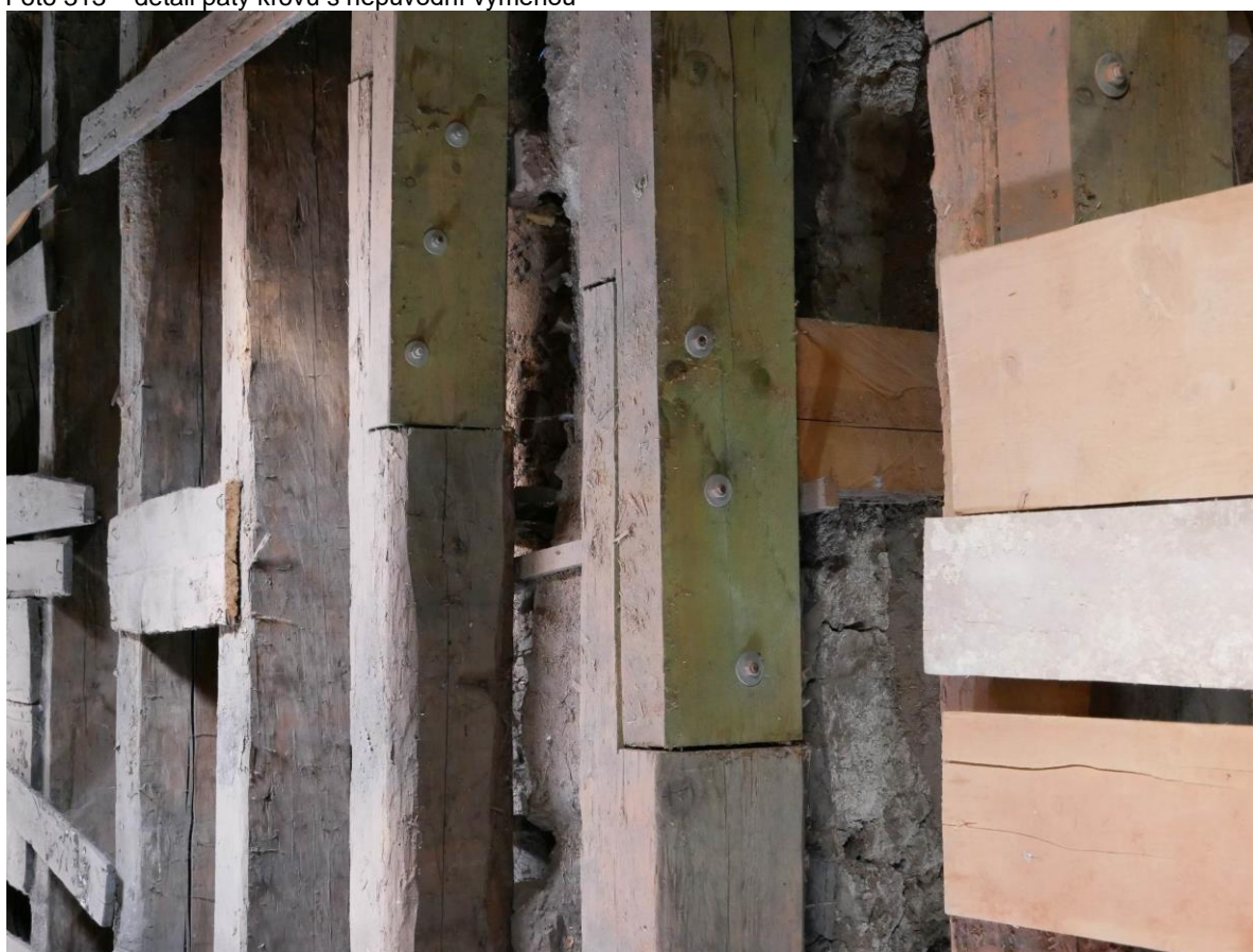
Foto 314 – detail vazných trámů nad klenbou sálu ve 2.NP. Nevhodné protézování a podpírání o rub klenby.
