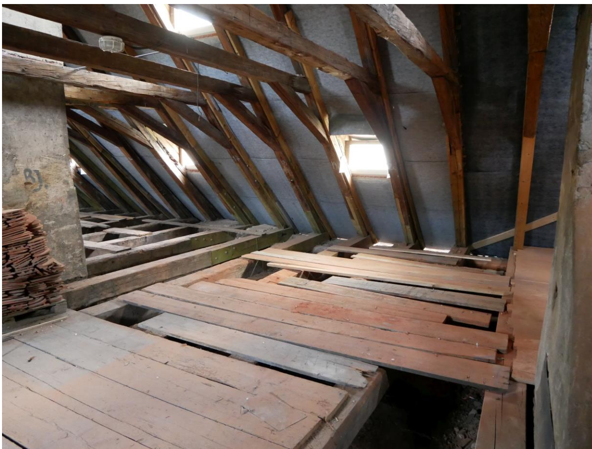
Foto 301 – podkrovní prostor, úsek určený k 2. etapě rekonstrukce. Chybějící a poničený záklop (podlaha), nevhodné malé vikýře určené k asanaci.
