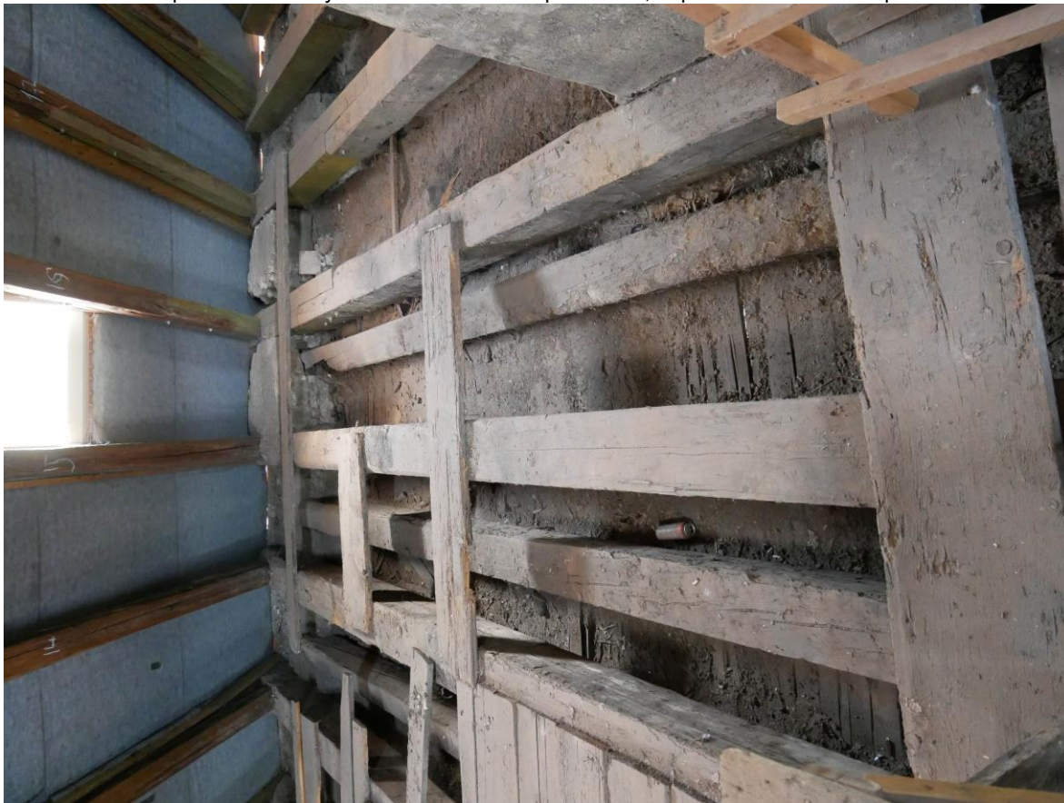
Foto 306 - chybějící záklop (podlaha) z fošen, poškození vazných trámů a rákosníků
