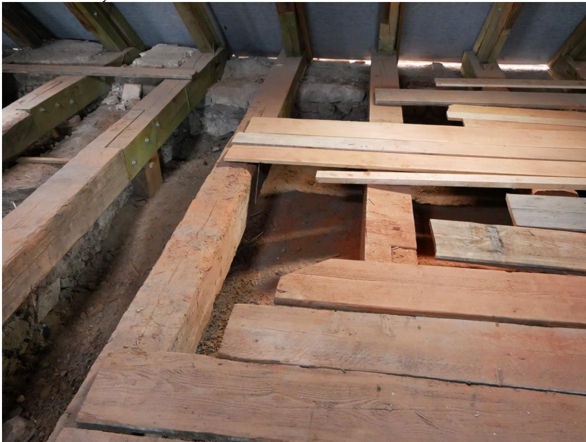
Foto 302 – vazné trámy nad klenbou, nevhodné protézování i podpírání o rub klenby
