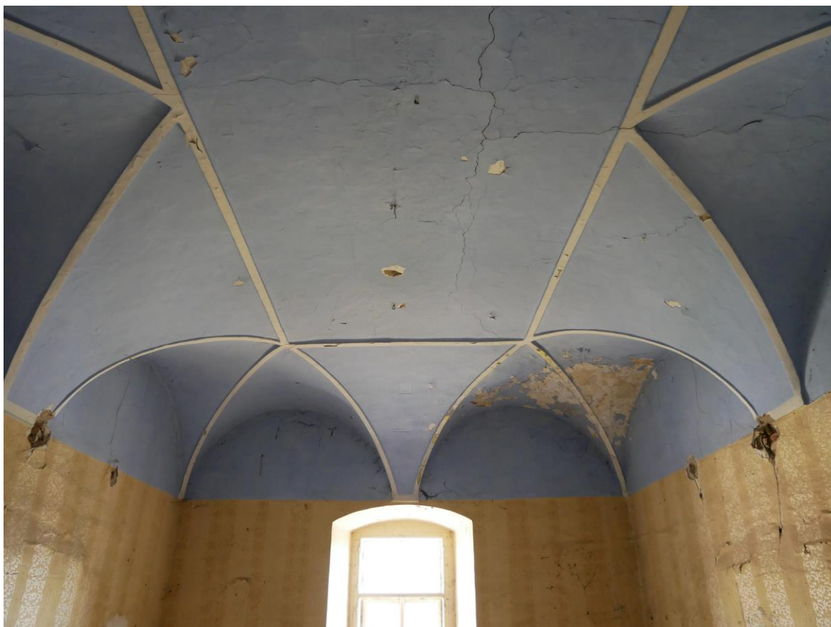
Foto 201 – sál ve 2.NP, klenba se zrcadlem a lunetami, zde krov bez rákosníků, opravy vazných trámů jen shora a bez podpírání o rub klenby!
