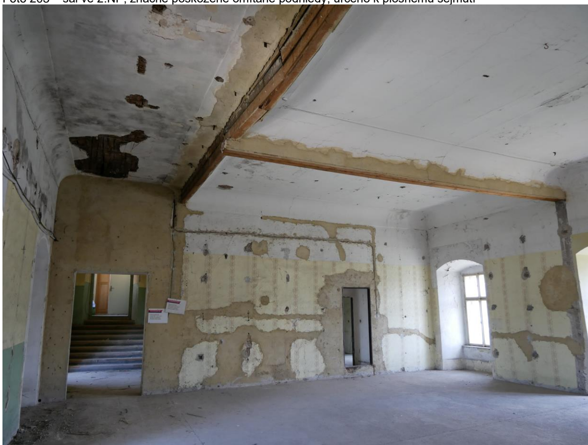
Foto 204 – týž prostor, jiný záběr, opravy rákosníků nebude možno provést bez sejmutí podhledu
