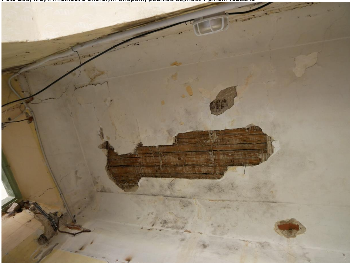
Foto 206 – strop v chodbě průchodu do prostor nad průjezdem zámku. Poškozený pohled sejmout v plném rozsahu
