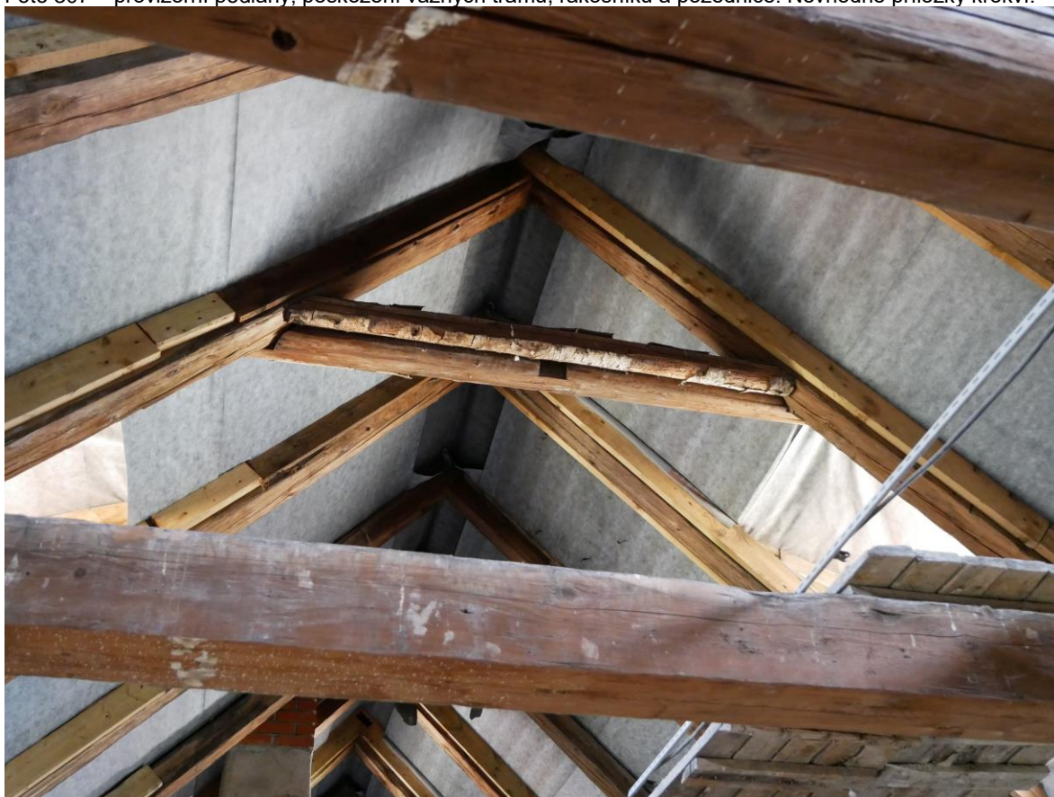
Foto 308 – provizorní a nevhodné novodobé opravy krovu, druhý hambalek a podivné příložky. Odstranit.
