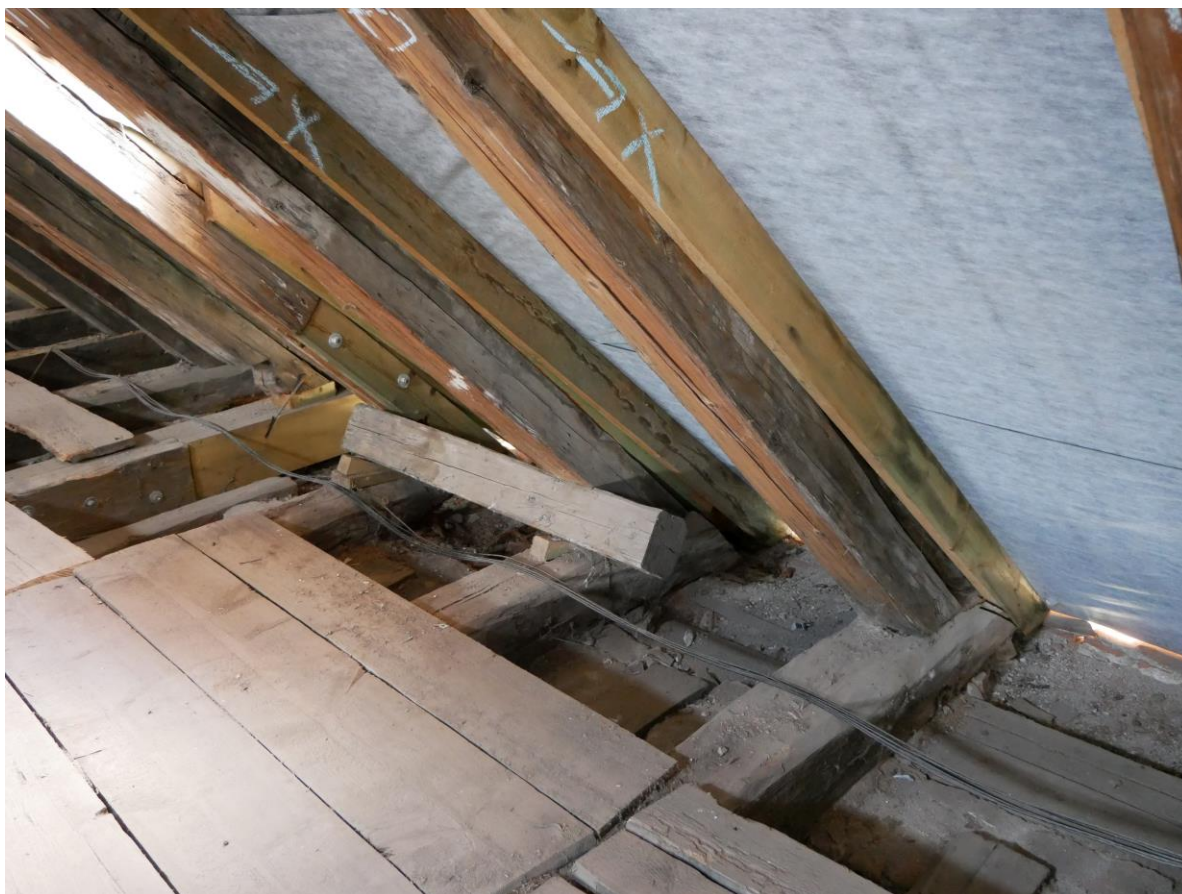
Foto 313 – detail paty krovu s nepůvodní výměnou
