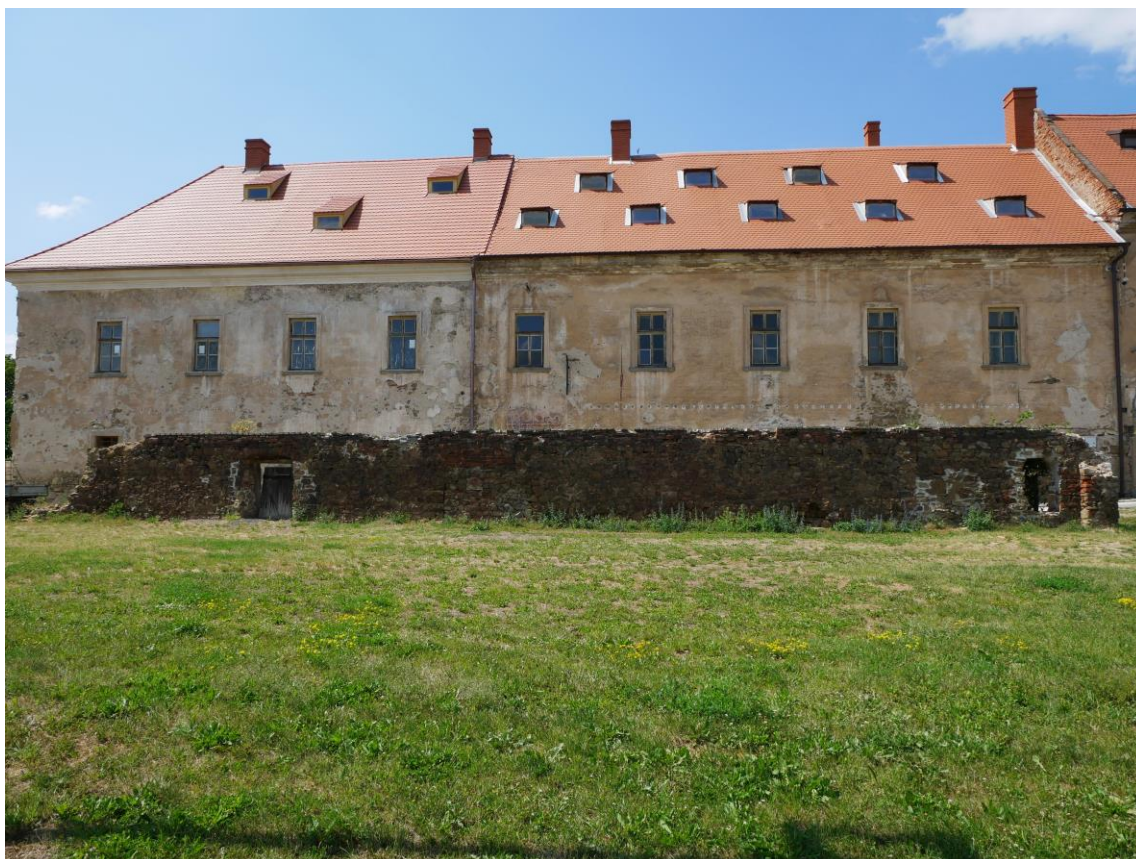
Foto 001 – jižní fasáda zámku, vlevo díl střechy po rekonstrukce, vpravo úsek určený k 2. etapě rekonstrukce
