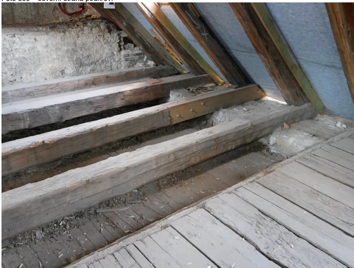
Foto 310 – podlaha půdy nad prostorem s ohořelým stropem ve 2.NP
