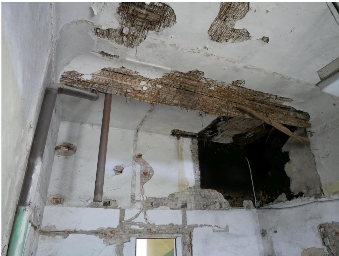
Foto 205, krajní místnost s ohořelým stropem, pohled sejmout v plném rozsahu
